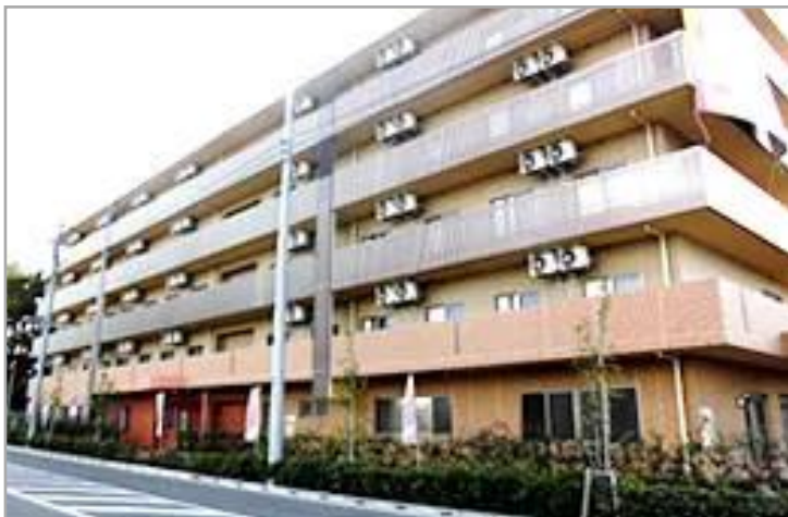
【ホームステーションらいふ小平】外観
