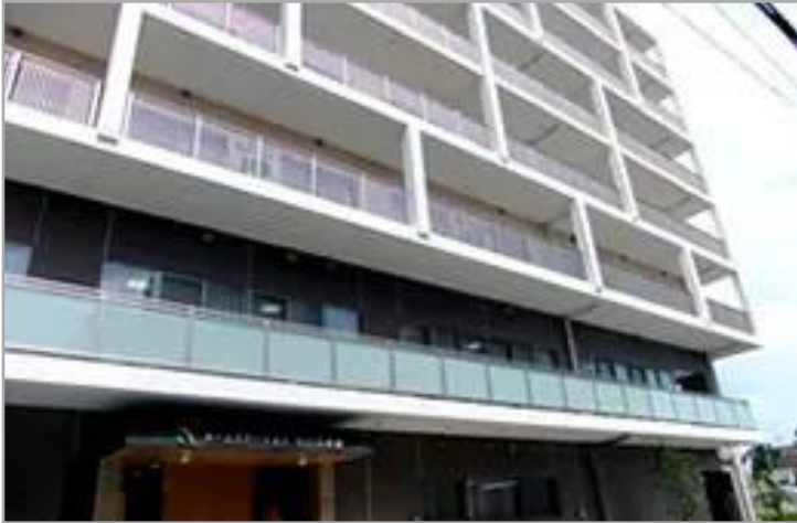
【ホームステーションらいふ清瀬】外観
