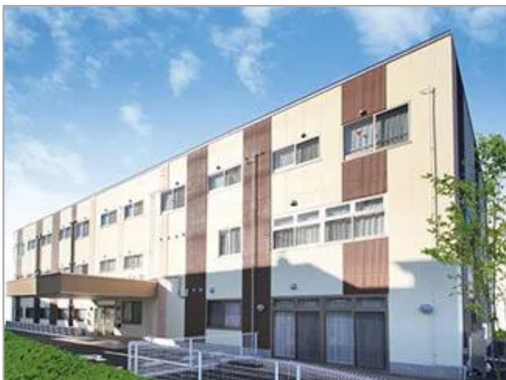
【福寿かわさき高津】施設外観
