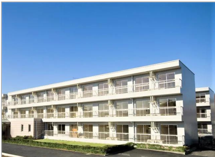
【ベストライフ所沢の外観】鉄筋コンクリート造の3階建ての建物です。
