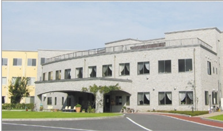
【あにもの森2号館の外観】
