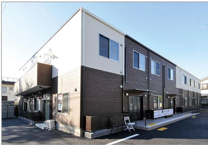
【グループホームきらら奥沢】施設外観
