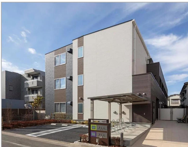
【グループホームきらら要町】施設外観
