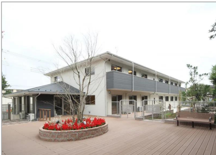
【グループホームきらら 高砂】施設外観
