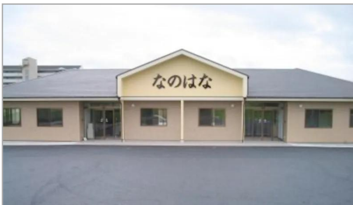
【プラチナホーム一宮なのはな・外観】
