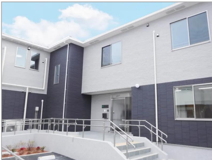
【みつばメゾン朝霞根岸台の外観】
