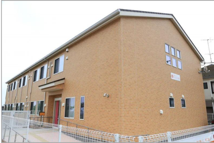
ドルフィン港北外観
