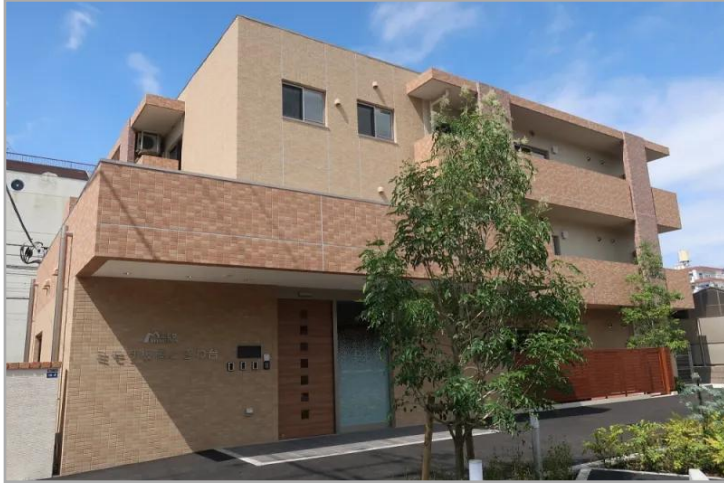
【ミモザ板橋ときわ台・外観】
