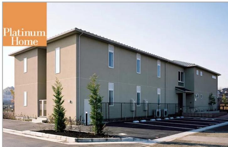
【プラチナホーム鴨志田・外観】
