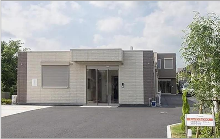
【ヒューマンライフケア大泉学園グループホーム・外観】
