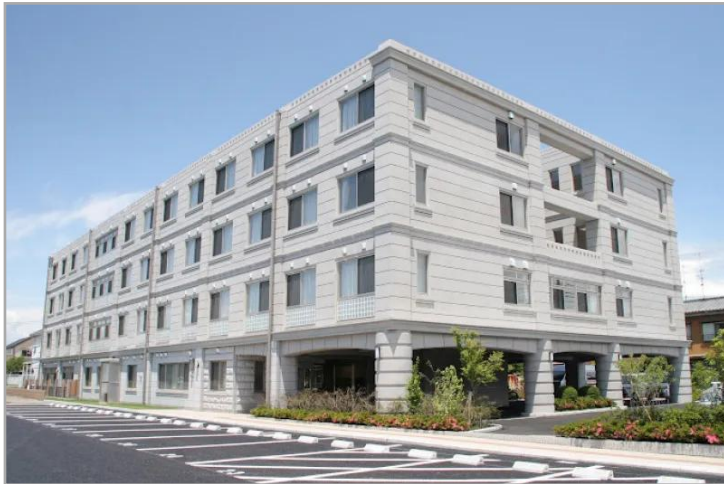
【ヒューマンサポート幸手の外観】デイサービス併設、駐車場完備です。
