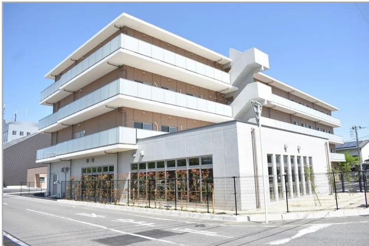
【ベストライフ高崎の外観】
