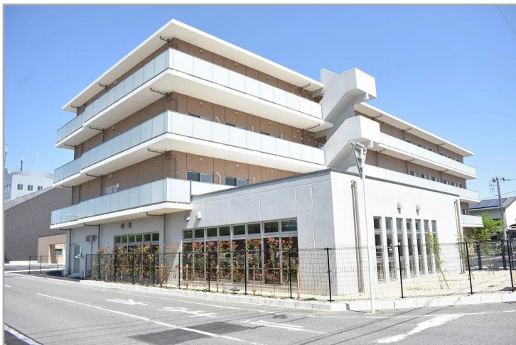
【ベストライフ高崎の外観】
