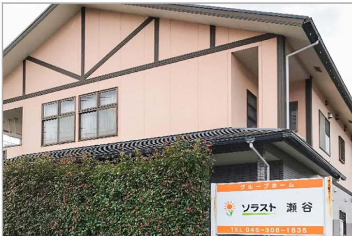
【グループホームソラスト瀬谷・外観】
