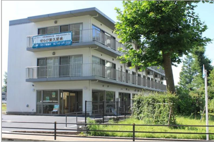
【せらび東久留米の外観】
