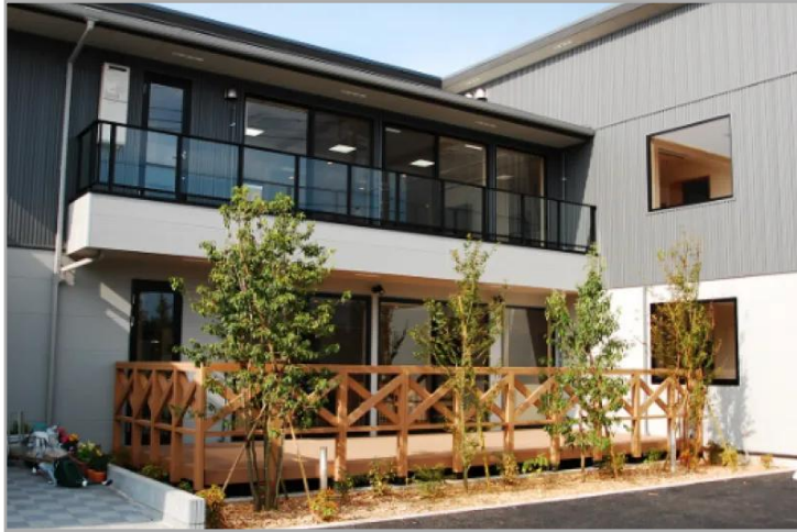
せらび小金原公園外観
