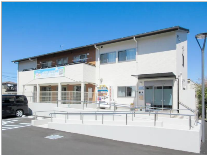
【愛の家グループホーム富士見上沢の外観】
