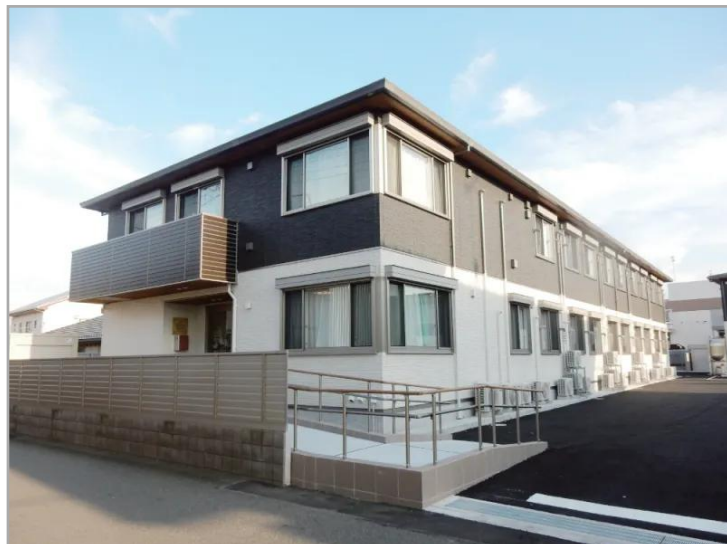
【みつばメゾン新座東棟の外観】
