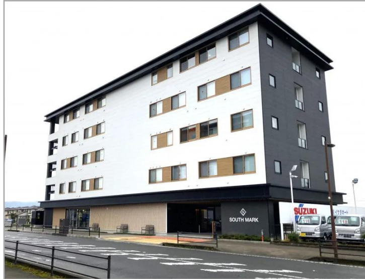
【ザ・プライム燈庵（とうあん）】施設外観
