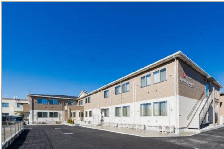
【ベストリハナーシングホーム春日部の外観】
