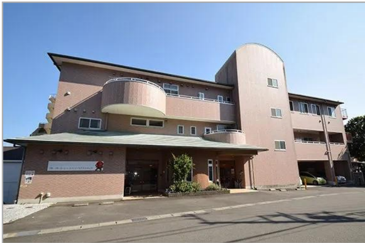
【あたま翔裕館】施設外観
