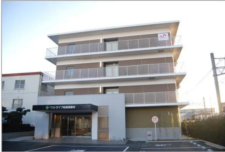
【ベストライフ船橋葉園台】外観
