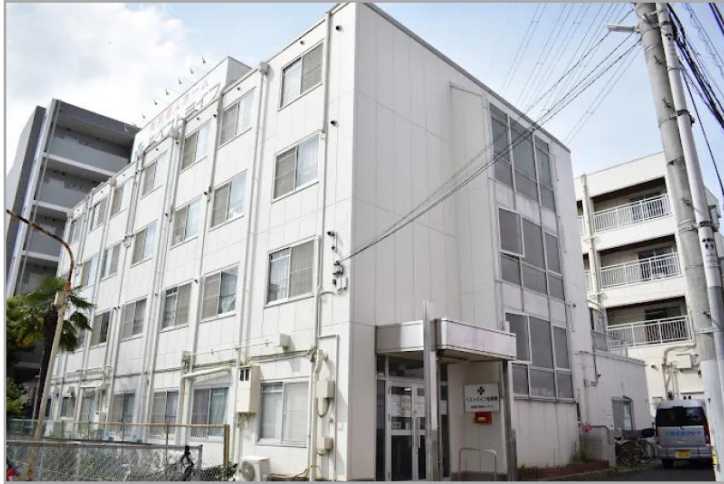
【ベストライフ船橋東・外観】
