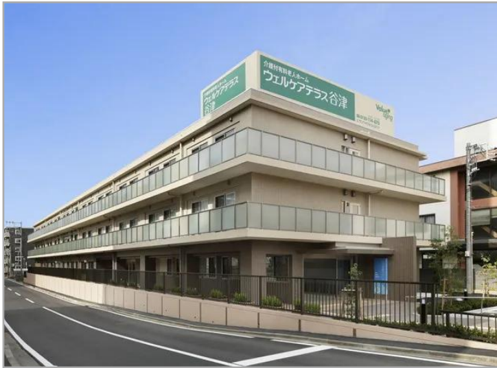
【ウェルケアテラス谷津】外観
