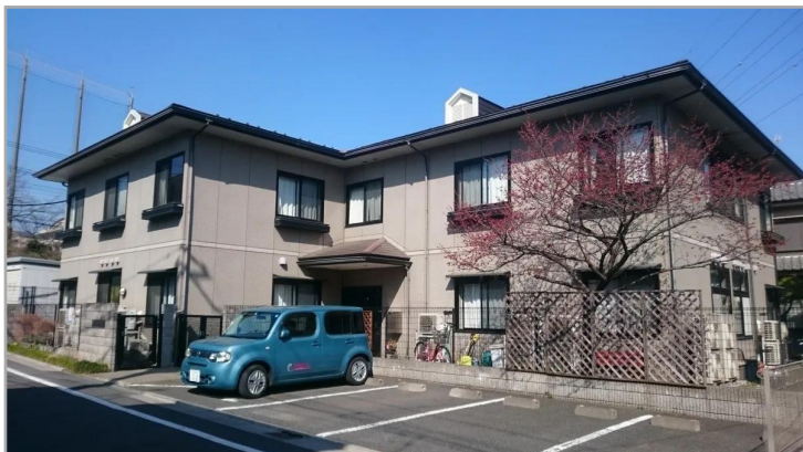
【グループホームふれあい多居夢浦和の外観】
