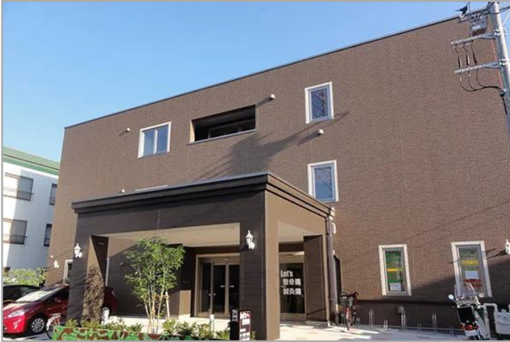
【夢叶う杜】外観
