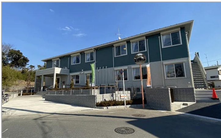
【ヒューマンライフケア川口新郷グループホームの外観】
