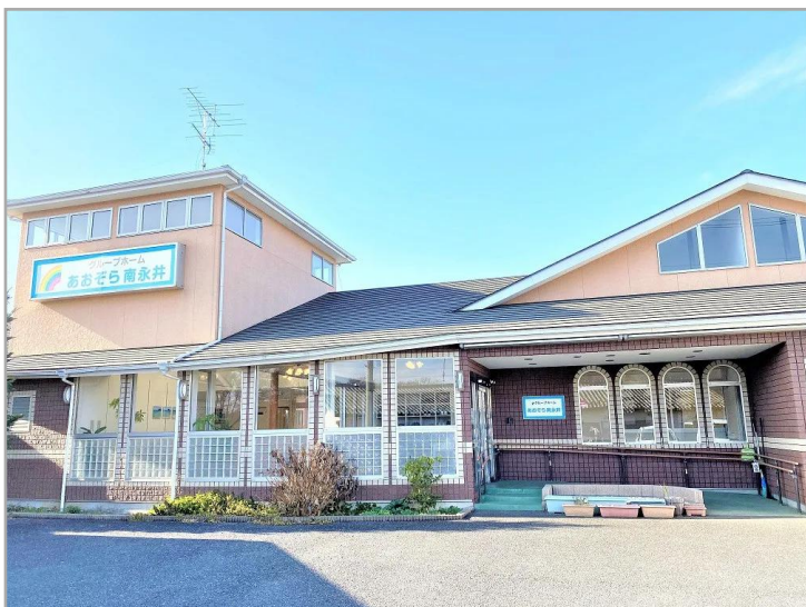
【グループホームあおぞら南永井の外観(2023年1月撮影)】
