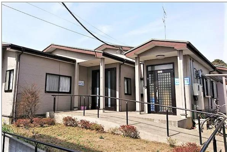
【グループホームあおぞら川角の外観】
