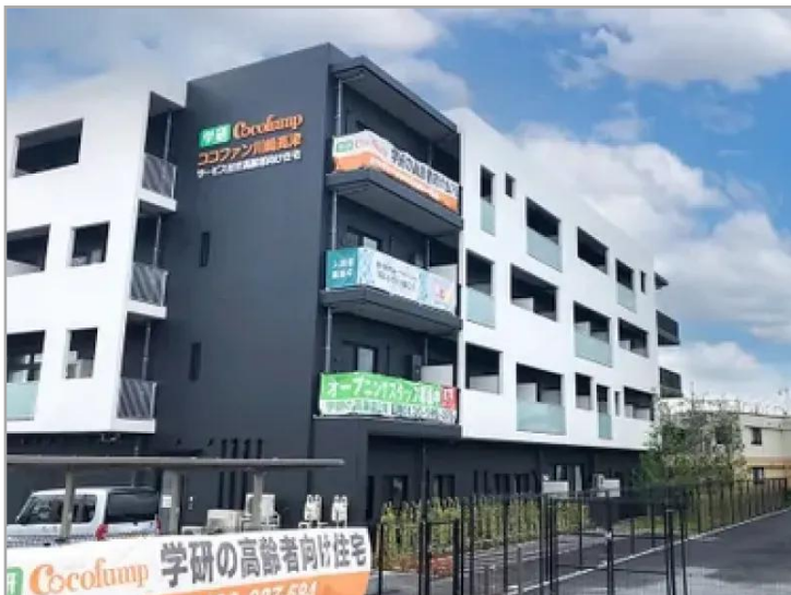
【愛の家グループホーム川崎蟹ヶ谷の外観】
