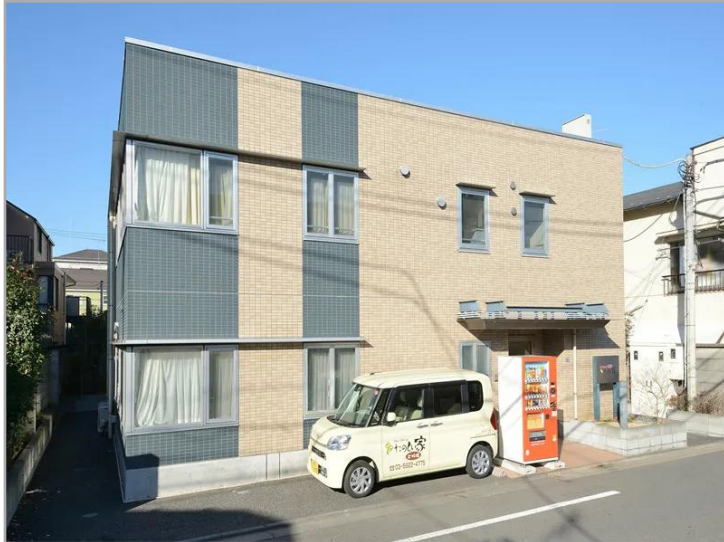
【グループホームたのしい家上板橋の外観】
