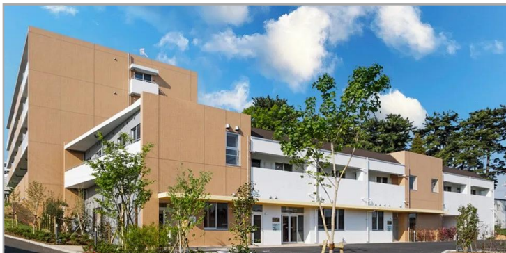
【ウェルミーテラス高根台の外観】
