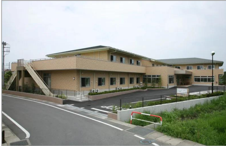
【あずみ苑グランデ太田の外観】
