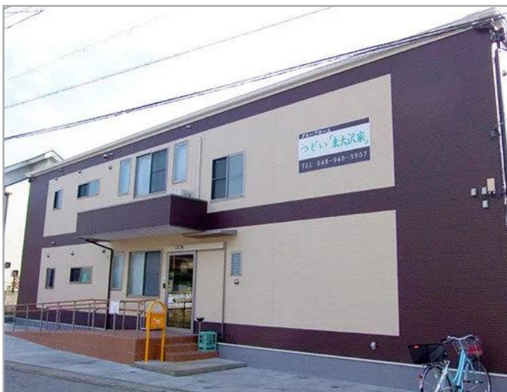
【グループホームつどい『東大沢家』】外観
