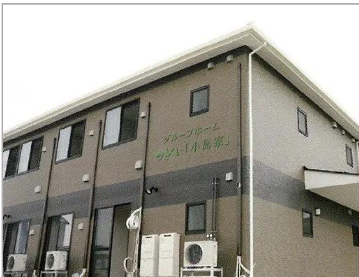
【グループホームつどい『小島家』】外観
