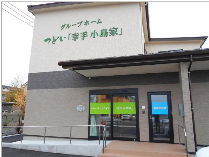
【グループホームつどい『幸手小島家』】外観
