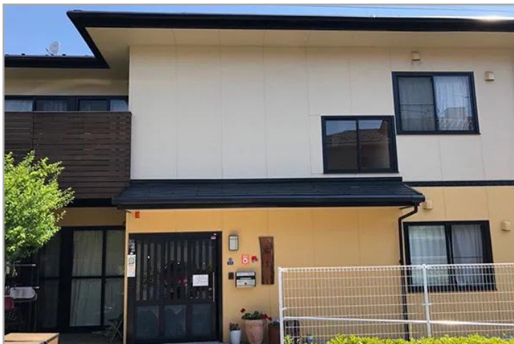
【ソラスト川崎麻生】外観
