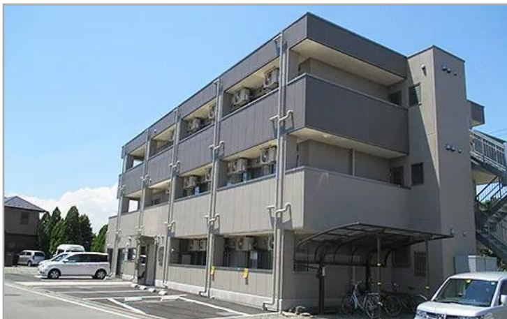
【ヒューマンライフケア八王子グループホーム】外観
