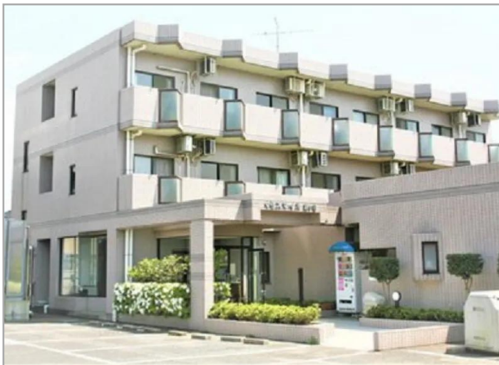
【ガーデンコート鎌ヶ谷の外観】
