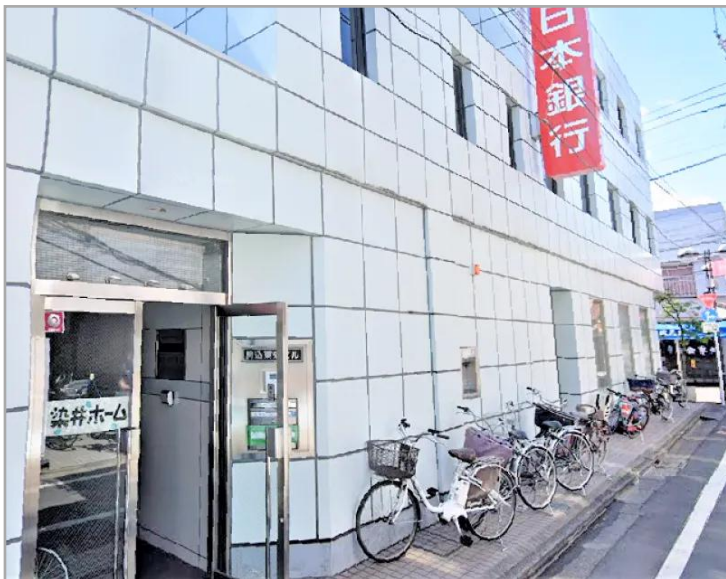
【ガーデンコート駒込染井の外観】
