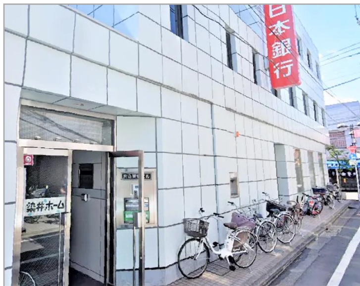
【ガーデンコート駒込染井の外観】
