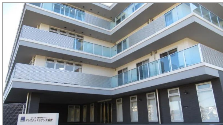
【アシステッドリビング浦賀】外観
