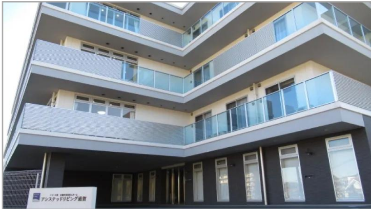
【アシステッドリビング浦賀】外観
