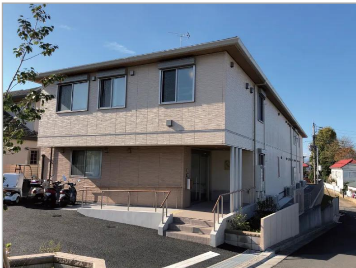
【住宅型有料老人ホームみつばメゾン富士見上沢の外観】
