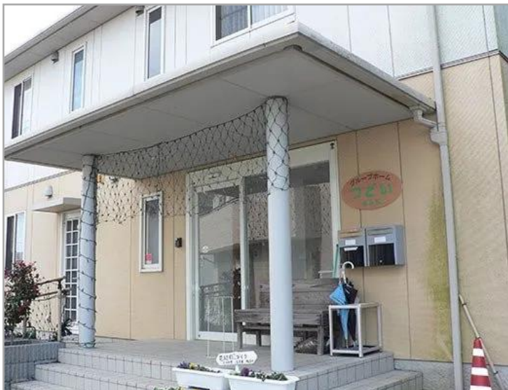
【グループホームつどい根本家の外観】
