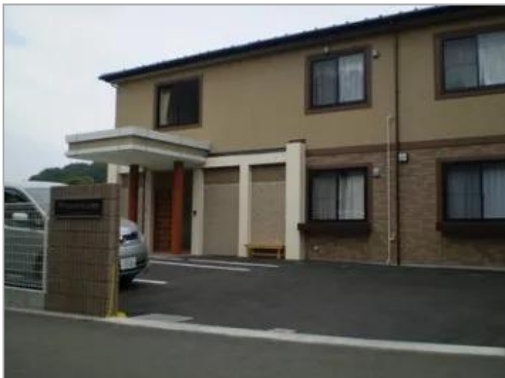
【セントケアホーム港南】外観
