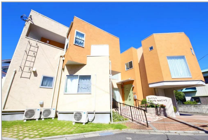
【グループホームちいさな手癒しの里横浜さかえ】外観
