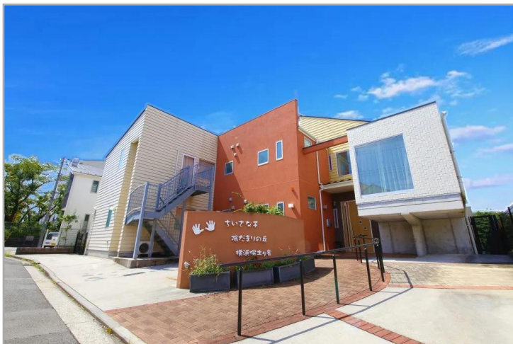
【グループホーム ちいさな手陽だまりの丘横浜保土ヶ谷】外観
