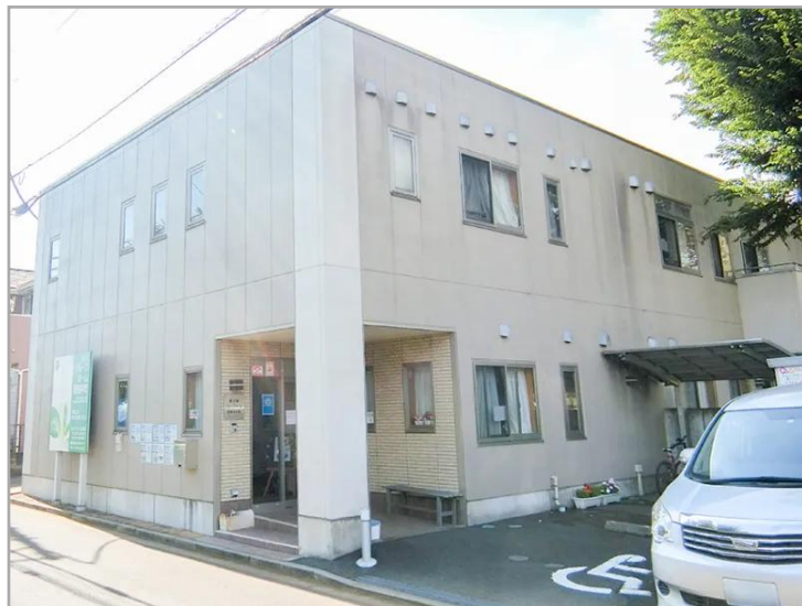
【愛の家グループホーム西東京中町の外観】
